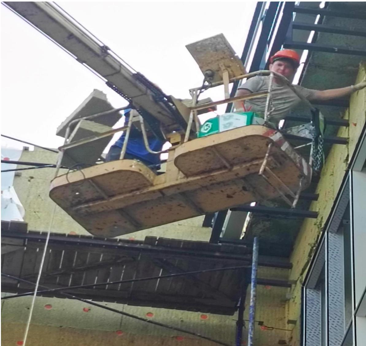
*Строительные материалы размещены непосредственно на ограждении платформы.
