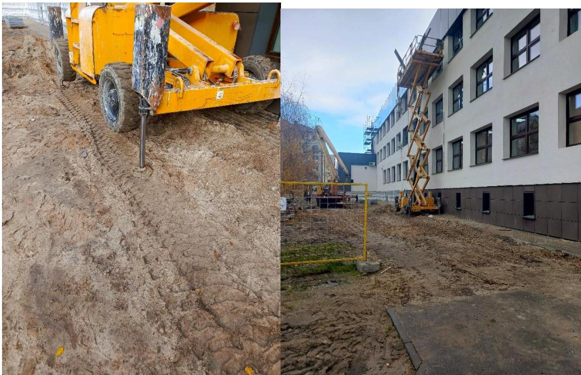
*Мобильная рабочая платформа установлена на неподготовленную площадку. Опоры установлены на насыпной грунт без подкладок. Не установлены ограждения и не обозначены в установленном порядке границы опасных зон.*
