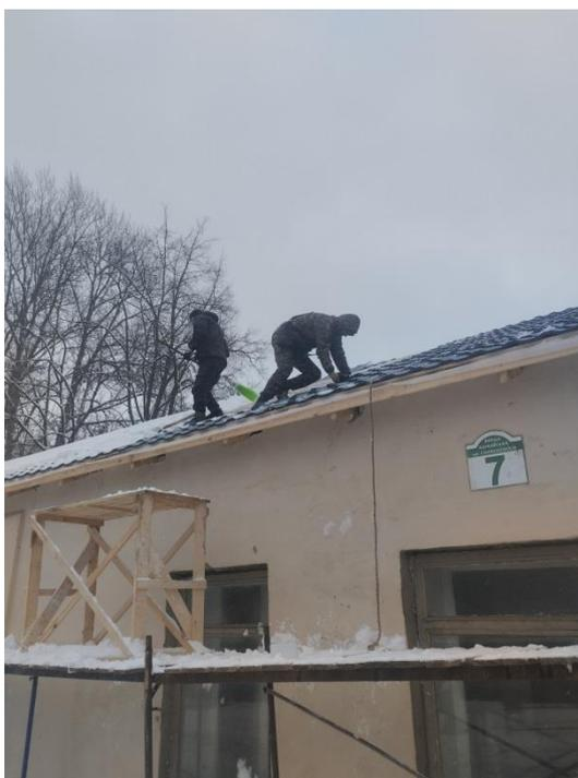
*При выполнении работ на крыше здания с уклоном более 20° рабочие не применяют предохранительные пояса, защитные каски и трапы с поперечными планками для упора ног.*
