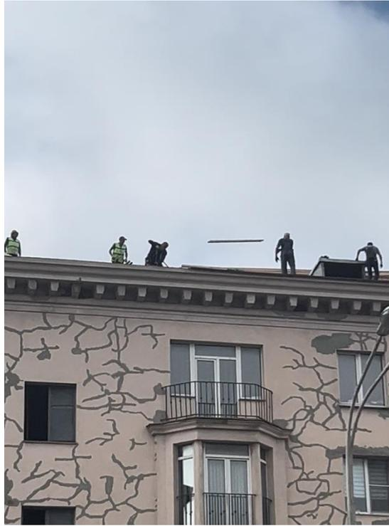
*При выполнении работ на крыше здания рабочие не обеспечены средствами индивидуальной защиты, в том числе предохранительными поясами.*
