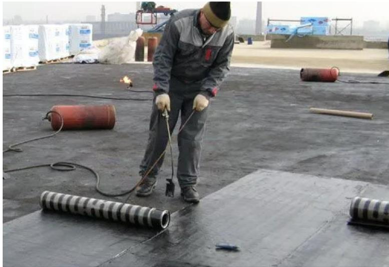
*При производстве кровельных работ газопламенным способом не соблюдены требования безопасности при размещении баллонов газом.*
